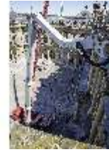
WüRes.I, Blick von Balustrade mit Kran, DI021024, BSV-
