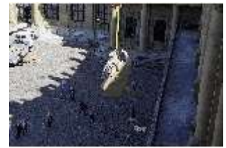
WüRes.I,P, Teil der neuen Balustradenfigur am Kran, DI021025, BSV-
