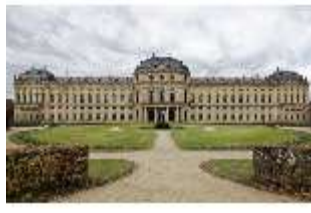
WüRes.I, Ostfassade und Ostgarten, DI007401, BSV
