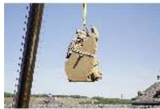
WüRes.I,P, Teil der neuen Balustradenfigur am Kran, DI021027, BSV-
