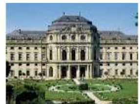
WüRes.I, Hofgartenfassade, Kaiserpavillon, DE000106, BSV-
