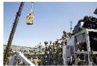
WüRes.I,P, Teil der neuen Balustradenfigur am Kran, DI021028, BSV-
