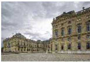
WüRes.I, West­fassa­de mit Ehrenhof und Frankoniabrunnen, DI007404, BSV
