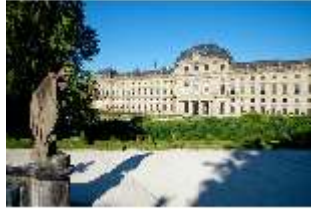
WüRes.I, Ostfassade, von der Promenade aus, DI007256, BSV
