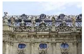
WüRes.I, Rechter Abschnitt der Westfassade, DI021038, BSV-
