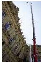
WüRes.I, West­fassa­de mit Kranarm, DI021019, BSV-
