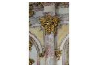
WüRes.II, Kaisersaal, R. 5, Säule mit verkröpftem Gebälk, DI012188, BSV
