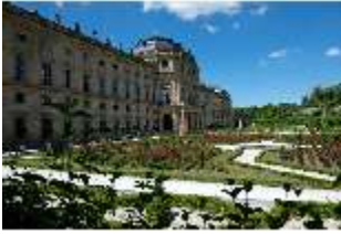
WüRes.I, Ostfassade von Süden aus, davor der Ostgarten, DI007305, BSV
