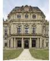
WüRes.I, Ostfassade, Kaisersaalpavillon der Residenz, DI007400, BSV
