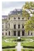
WüRes.I, Hofgartenfassade, Kaiserpavillon, DI021051, BSV-
