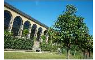
WüRes.V, Orangerie, Südfassade mit Küchengarten, DI006930, BSV
