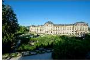
WüRes.I, Ostfassade, von der Promenade aus, DI007208, BSV
