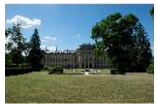
WüRes.I, Ostfassade mit Kaisersaal, DI007310, BSV
