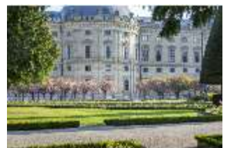
WüRes.I, Südfassade, davor blühende Baumallee und Rasenparterre, DI008978, BSV
