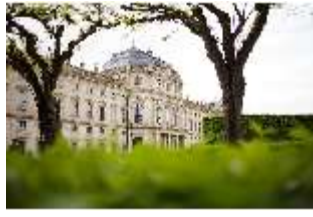
WüRes.I, Kaisersaalpavillon, Ostfassade, DI028677, BSV-
