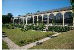
WüRes.V, Orangerie, Südfassade, DI007387, BSV
