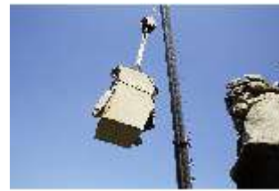
WüRes.I,P, Teil der neuen Balustradenfigur am Kran, DI021023, BSV-
