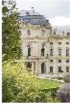
WüRes.I, Kaisersaalpavillon, Ostfassade, DI028691, BSV-
