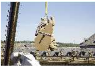
WüRes.I,P, Teil der neuen Balustradenfigur am Kran, DI021026, BSV-
