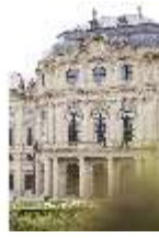
WüRes.I, Kaisersaalpavillon, Ostfassade, DI028687, BSV-
