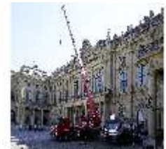
WüRes.I, Ehrenhof mit Kran vor der Westfassade, DI021017, BSV-
