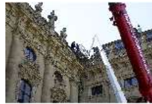
WüRes.I, West­fassa­de mit Kranarm und Hubarbeitsbühne, DI021020, BSV-
