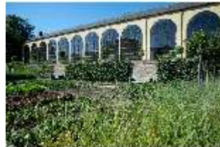
WüRes.V, Orangerie, Südfassade mit Küchengarten, DI007390, BSV
