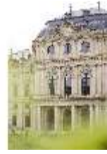
WüRes.I, Kaisersaalpavillon, Ostfassade, DI028688, BSV-
