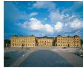
WüRes.I, West­fassa­de in der Gesamt­breite, DE000062, BSV-
