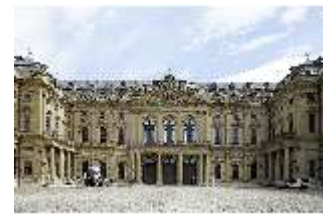
WüRes.I, West­fassa­de mit Ehrenhof, DI021039, BSV-
