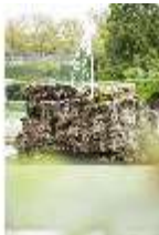
WüRes.V, Wasserbecken, Ostgarten, DI028759, BSV-
