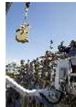
WüRes.I,P, Teil der neuen Balustradenfigur am Kran, DI021029, BSV-
